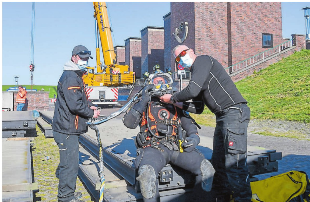
Sebastian Plugge (links) und Tobias Hartung (rechts) bereiten Marco Wiedner auf seinen Tauchgang am Dangaster Siel vor. Das Bauwerk wird saniert.
