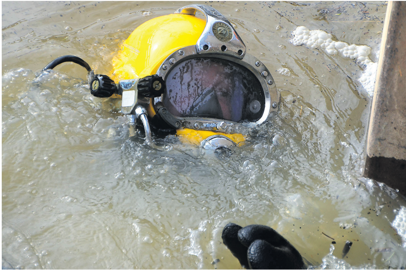
Einsatz am Motzener Kanal: Taucher Tobias Hartung muss für die spätere Brücke mehrere Kilogramm Spezialbeton auf dem Fundamentfuß verteilen. Bei solchen Einsätzen geht man an seine Leistungsgrenze, sagt der 46-Jährige. BILD: GABRIELE BODE
